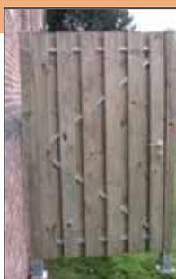
Porte montée finition verticale sur un cadre en métal galvanisé, les gonds Ø16 et système de charnière réglable y compris.
